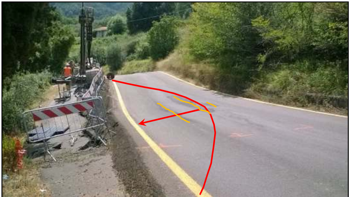
Fig. 3: Rottura del manto stradale fino ad interessare tutta la sede stradale, per effetto della frana attiva al km 2+200. In arancione le lesioni recenti, in rosso il cerchio ipotetico attuale di distacco.
